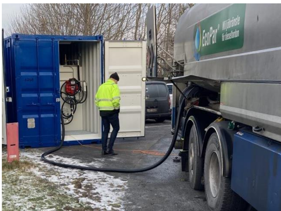
Figur 5 Bränslepåfyllnad av reservkraftanläggning
