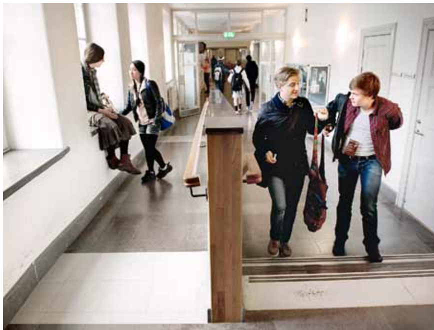
En ramp, som smälter in i skolans gamla arkitektur, har byggts i en av korridorerna. Trappan intill har målats vit för att synas bättre.
