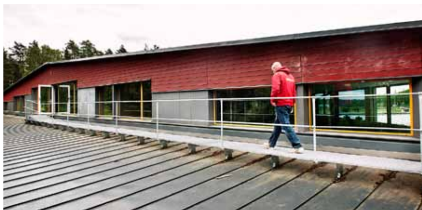
Rampen fortsätter ut på taket, som är den frångängliga utrymningsvägen.
