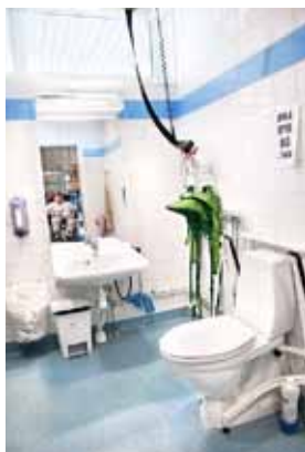
Vänster: Avfasad trottoarkant gör det enklare att ta sig fram för den som använder rullstol. Mitten: En tillgänglighetsanpassad toalett ska ha gott om utrymme. Här finns även en lyftanordning. Höger: Dörrar kan också öppnas automatiskt med hjälp av en fjärrkontroll.
