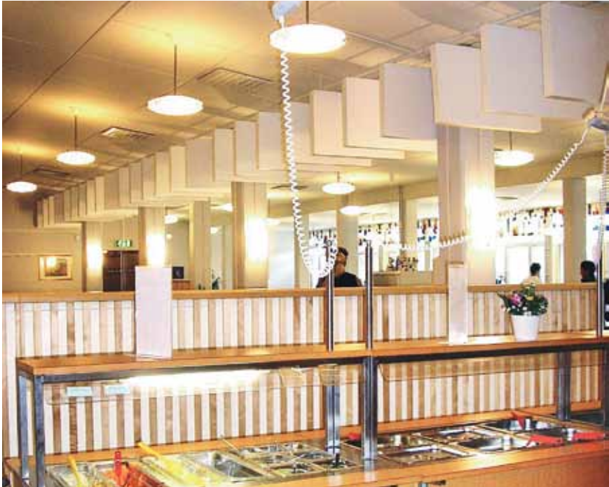
Horisontella och vertikala ljudabsorbenter i tak, samt ljudabsorberande skärm mellan serveringsbord och sittplatser. Matsal i Flatåsskolan, Göteborg
