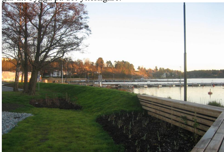
Figur 2, översvämningsskydd vid Nora strand
